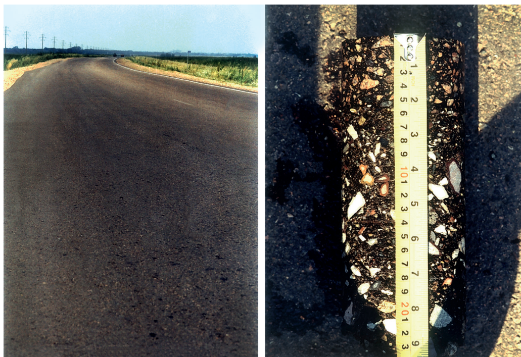
Рисунок 8 – Автодорога «Астана-Боровое», год строительства 2002 г., керн высверленный из асфальто-минерального бетона дороги (фото 2005 г.)
